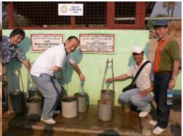
立派な井戸が完成！
